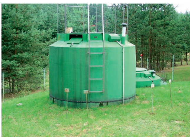
Oczyszczalnia typ BIO CLERE, fot. T. Szymaniuk
