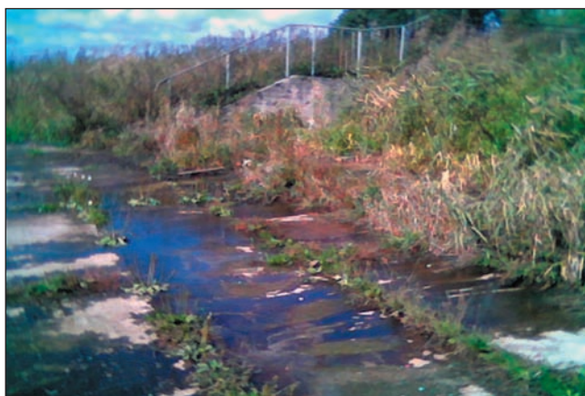
Widok gnojówki wypływającej z laguny służącej do jej gromadzenia, spływającej po drodze z płyt betonowych w rejon zagłębienia
