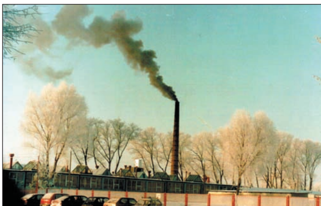
Kotłownia zakładu drzewnego - nadmierna emisja zanieczyszczeń do powietrza
